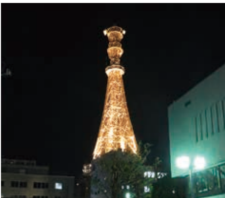
東北電力ネットワーク無線鉄塔
