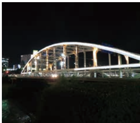
盛岡市 開運橋
